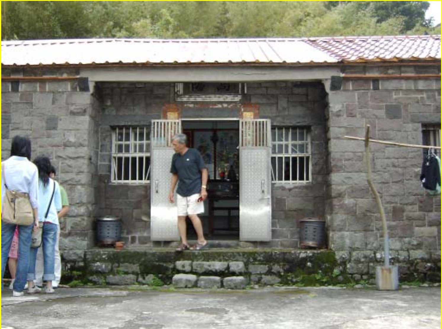
陽明山國家公園就地取材以安山岩所蓋之傳統民居—北投區湖山里湖底社區許姓三合院(門楣堂號「高陽」)
