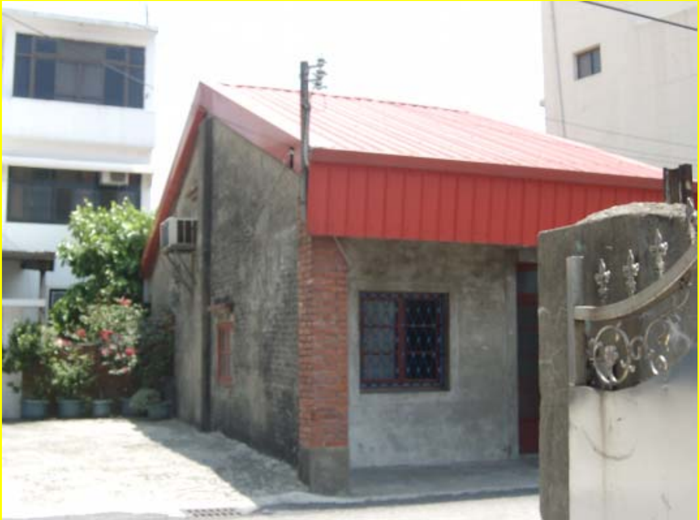
民國50-60年代興建之閩南式改良式磚造覆瓦民居
