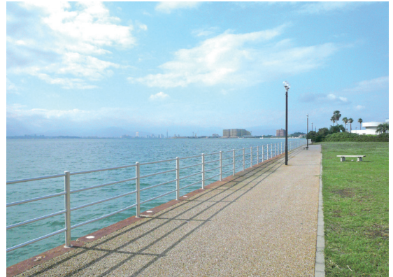
照片2 博多港水泥護岸隨處可見
