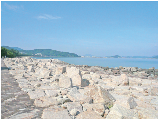
照片12 以自然塊石堆砌的護岸
