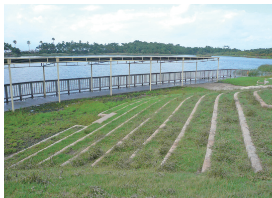
照片4 海岸濕地賞鳥平台及階梯護岸
