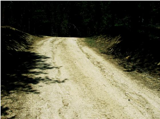
▲照片7 林道路面已有明顯的沖蝕溝。
